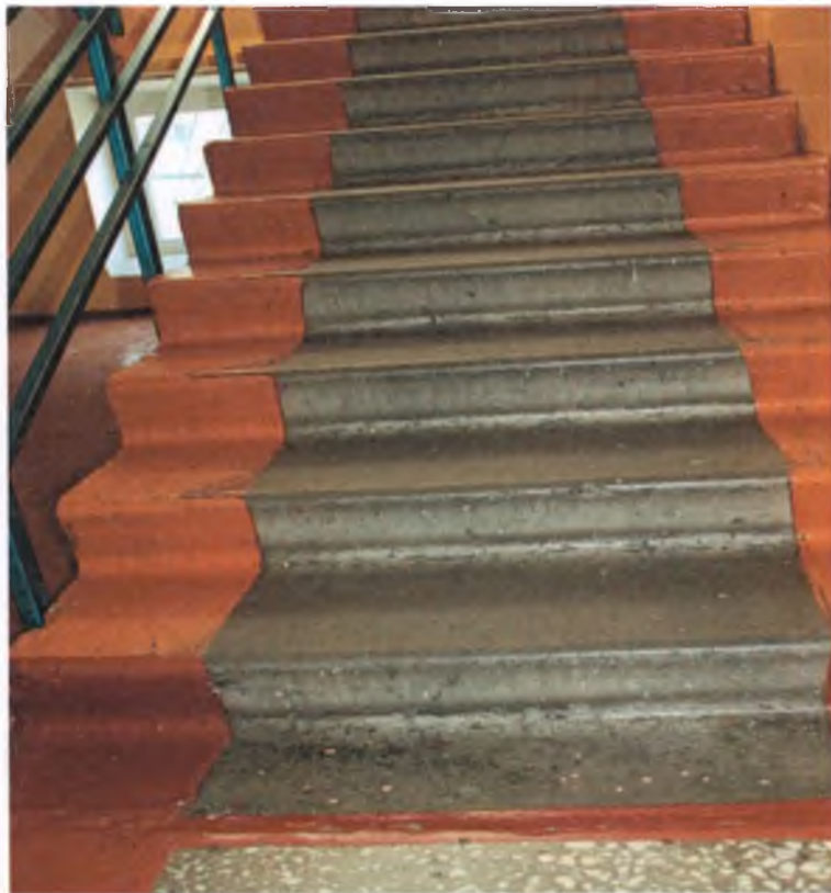
№ 16. Лестница внутри здания (на 2 этаж)
