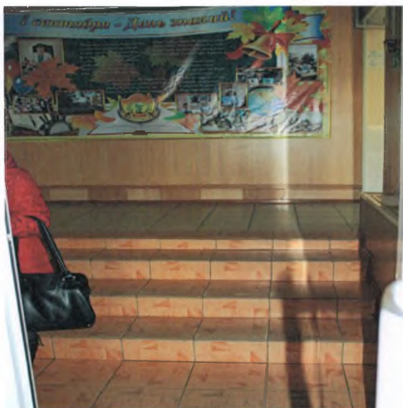
№ 14. Лестница внутри здания (коридор, вестибюль)
