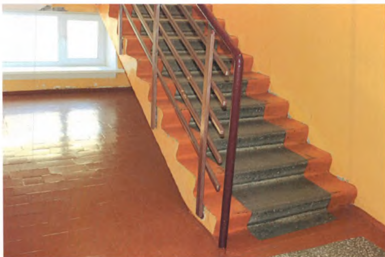
№ 20. Эвакуационная лестница (1 этаж)
