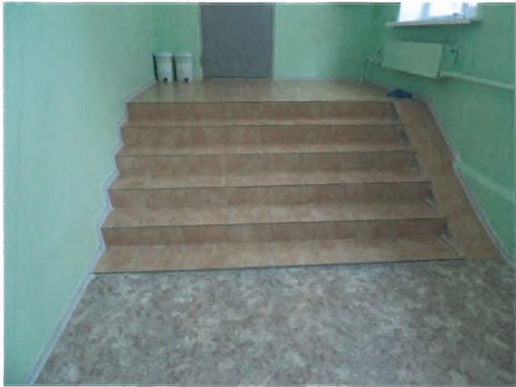
№ 15. Лестница внутри здания (при входе в бассейн)
